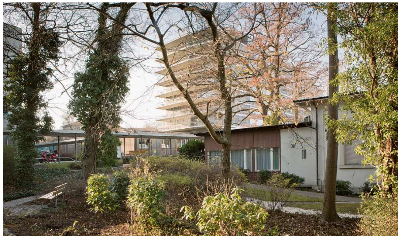
Gefährdeter Bau. Blick auf die Stirnseite des Felix-Platter-Gebäudes mit den ausladenden Balkonen. Foto Kostas Maros
